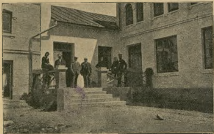
Ryc. 20. Szpital w Łosicach—główne wejście.
