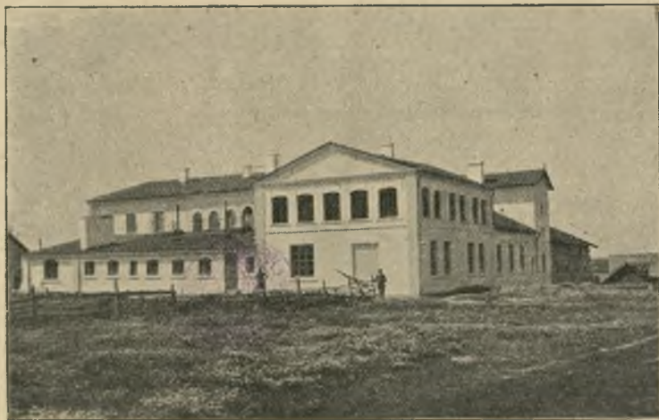
Ryc. 19. Szpital w Łosicach — widok ogólny.
