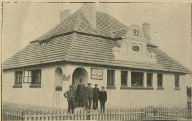
Ryc. 30. Zakład kąpielowo-dezynsekcijny w Złoczewie (pow. Sieradzkiego, Ziemi Kaliskiej).
