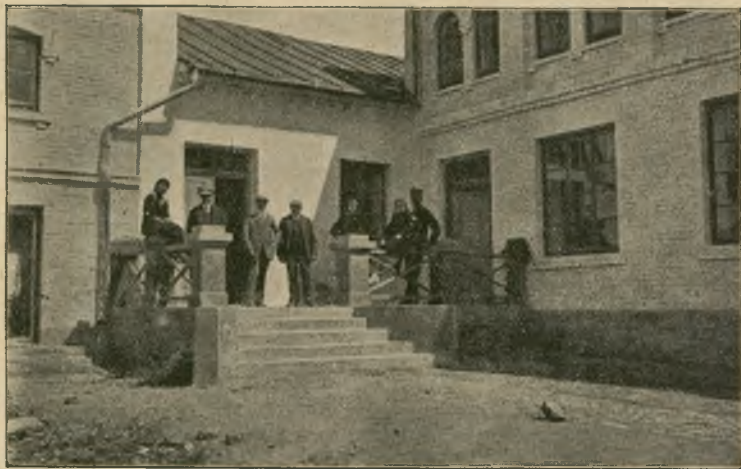
Ryc. 20. Szpital w Łosicach—główne wejście.
